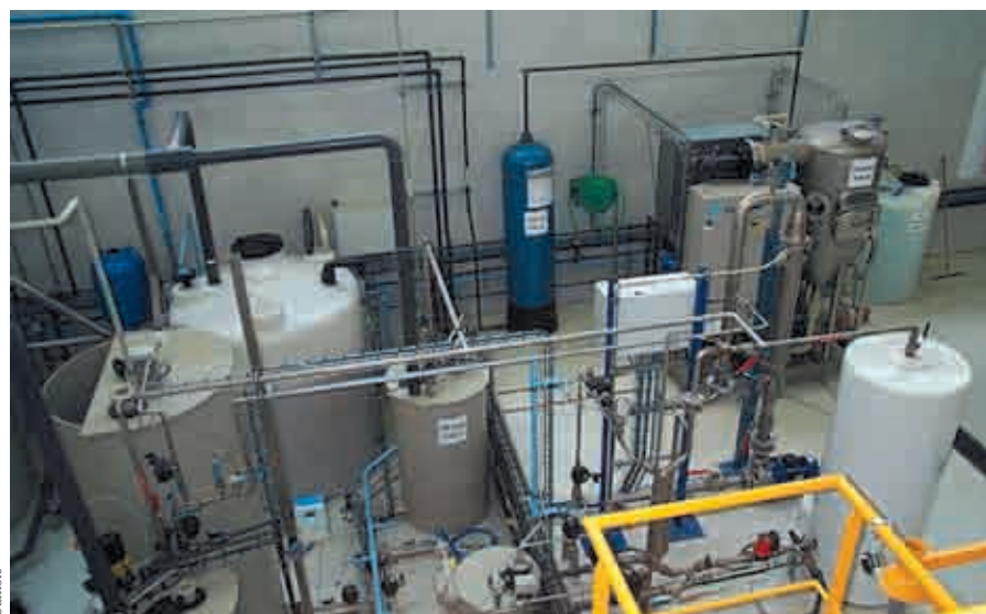
Installation de traitement en rejet zéro d'effluents de dégraissage, et huiles solubles avec évapo-concentration et ultrafiltration réalisée par Callisto.
